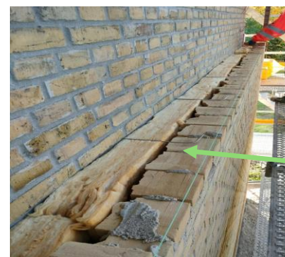
Billede 7 – Isoleringen lægges bag stenen. Det færdige produkt ses på billedet til venstre og på forsiden. Se billederne på hjemmesiden Kildevaenget.dk
