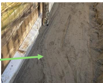
Billede 2 – Der er gravet ud. Der er sat rundt metal pæle til at bære isoleringsvæggen.
