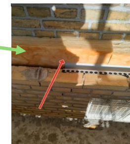
Billede 7 – Isoleringen lægges bag stenen. Det færdige produkt ses på billedet til venstre og på forsiden. Se billederne på hjemmesiden Kildevaenget.dk
