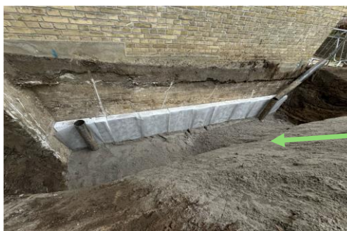
Billede 2 – Der er gravet ud. Der er sat rundt metal pæle til at bære isoleringsvæggen.
