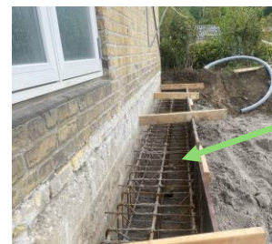
Billede 5 – Der bindes jern så der kan gøres klar til støbning af beton til at bære isoleringsvæggen.
