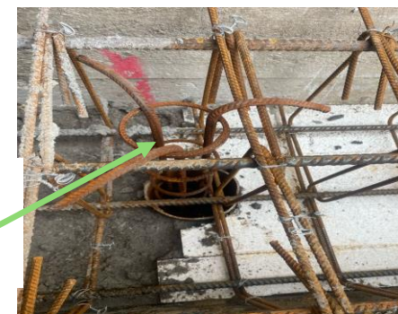
Billede 5 – Der bindes jern så der kan gøres klar til støbning af beton til at bære isoleringsvæggen.
